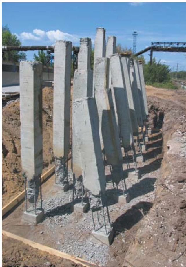
Рязань, май 2012 года. Свайное поле, подготовка под ростверк
